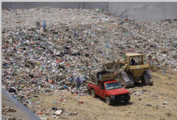
Imagen de relleno sanitario
